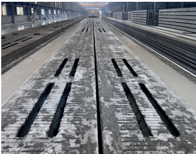
Hall de production avec quatre longs bancs de coulée à l'usine de Daewoo ST
