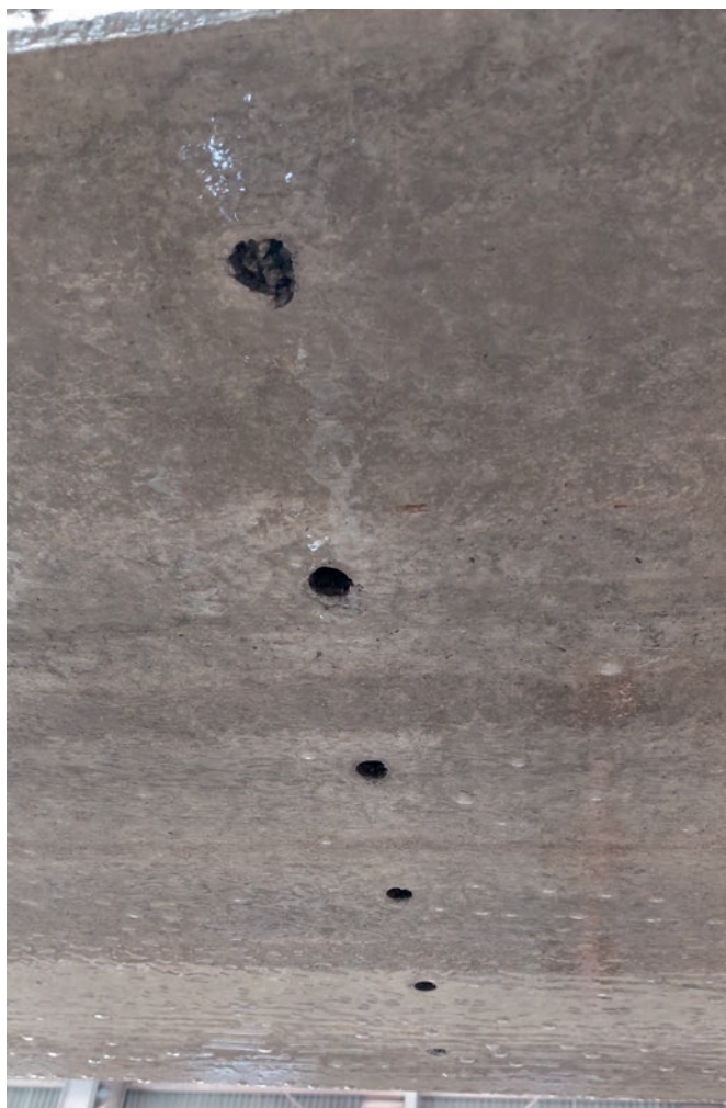
Trous d'évacuation de l'eau visibles sur la face inférieure des dalles alvéolées
