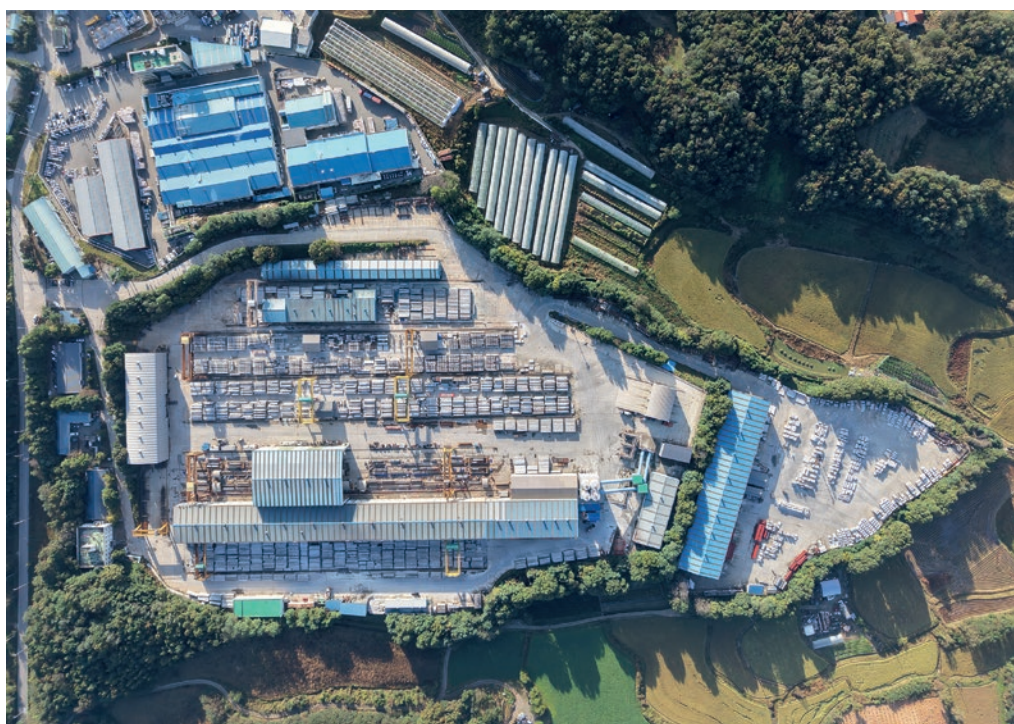
Vue aérienne du site de production de Daewoo ST à Jincheon, en Corée du Sud
